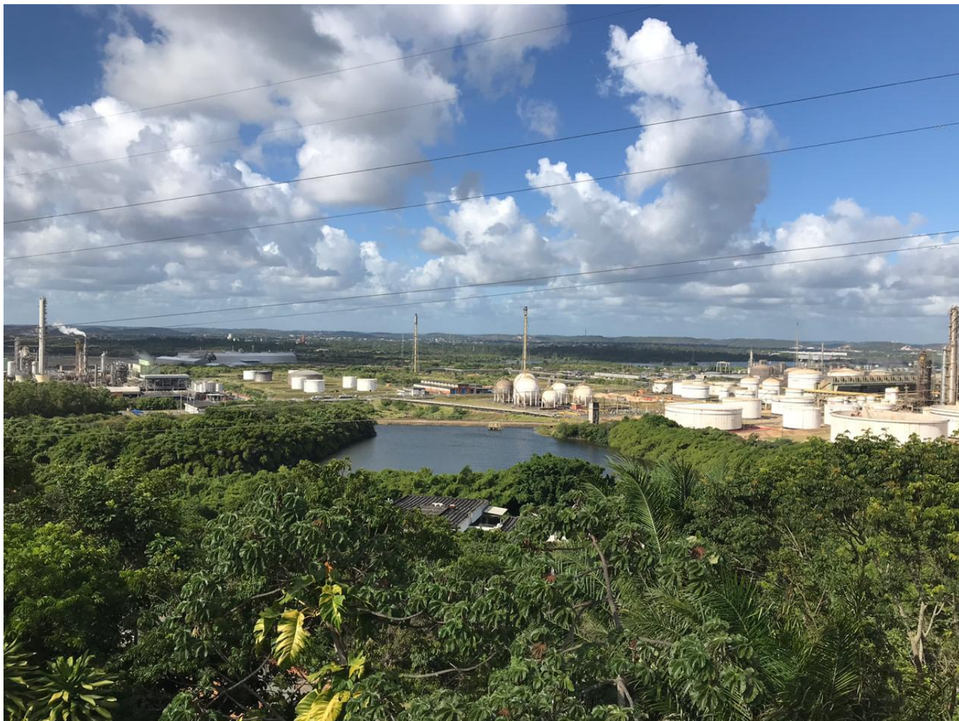
Imagem 2: Barragem RS2 – Cetrel.
