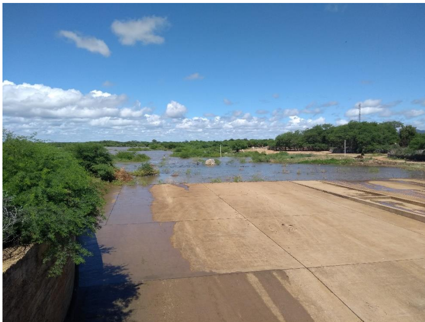
Imagem 3: Início de saída de água pelo vertedouro da Barragem de Pinhões.
