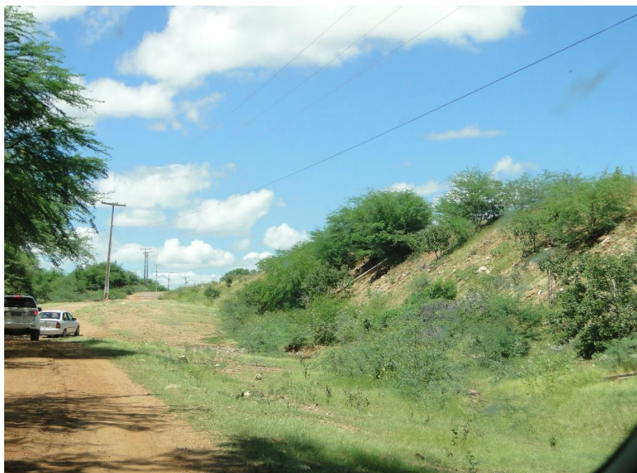
Imagem 7: Talude de jusante – lado implantado para a duplicação da rodovia.
