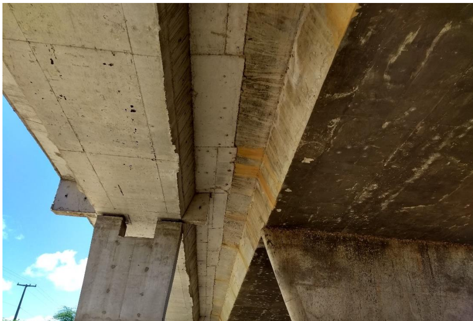
Imagem 6: Estrutura de sustentação da rodovia por sobre o vertedouro.
